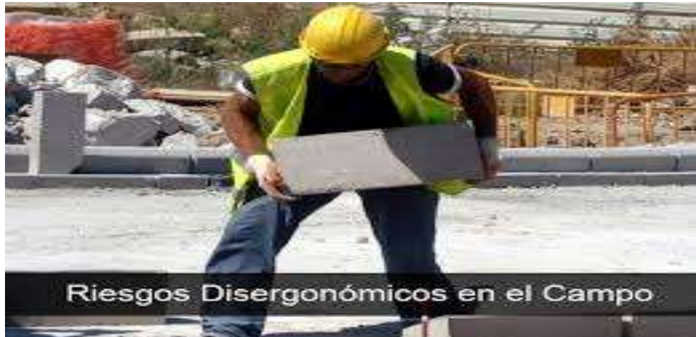
Figura N° 09: Riesgos Disergonómico Fuente: calameo capacitación
